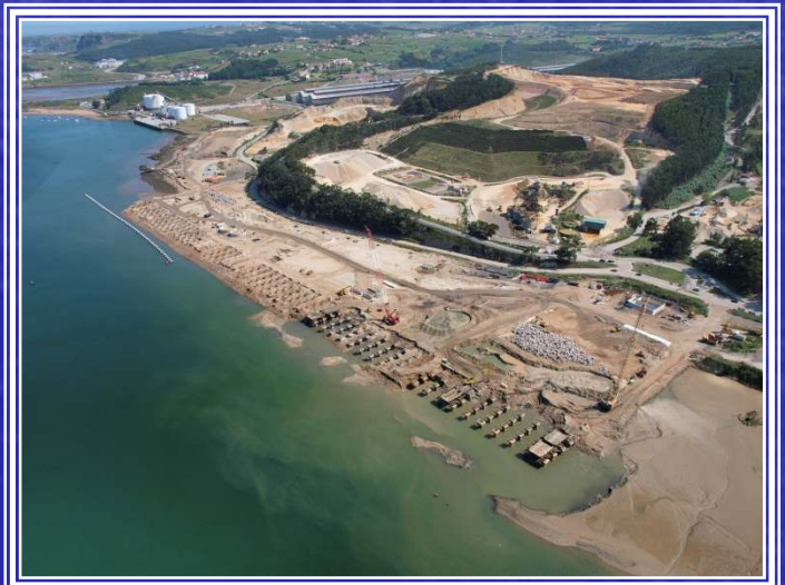
Ampliación Puerto Avilés Margen Derecha
