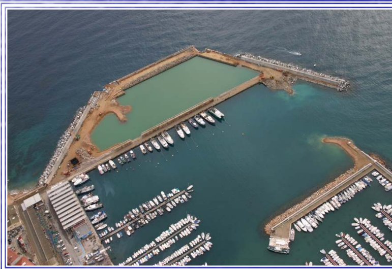
Ampliación Puerto de Blanes
