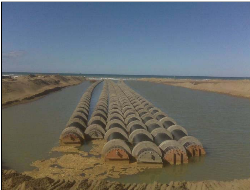
Mostaganem: tuberías flotando en una zanja hecha en la playa, antes de ser transportadas a su destino
