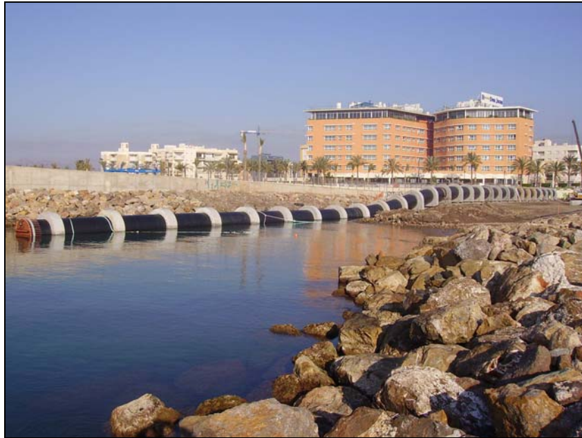
Águilas: la tubería de toma, durante su lanzamiento en la costa
