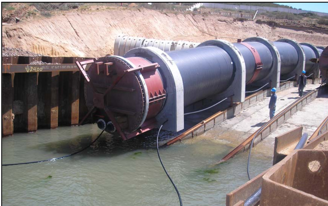
Beni Saf: Imagen del lanzamiento de las tuberías hacia el mar, para su transporte flotando
