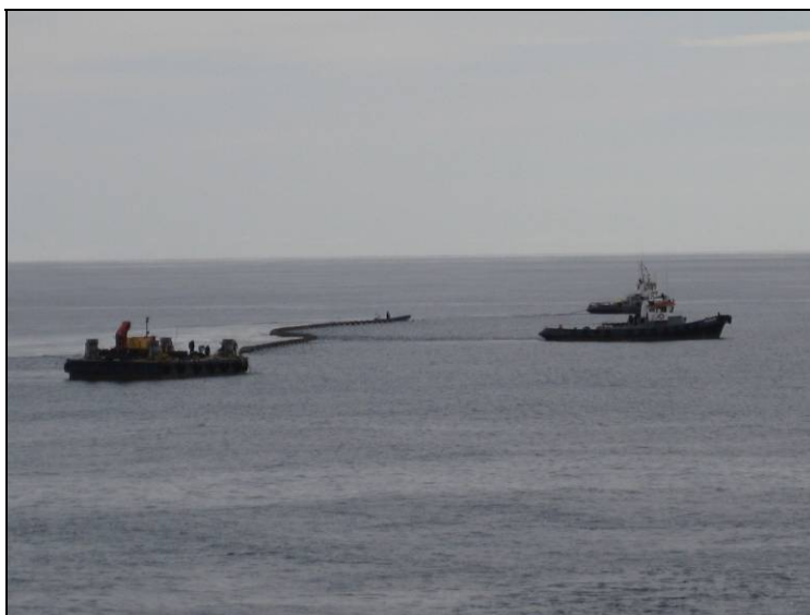
Fondeo del emisario de Arinaga (Gran Canaria)
