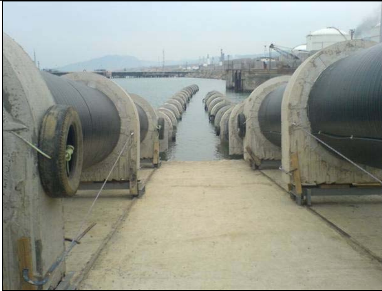
Skikda: tuberías durante su lanzamiento en el Puerto
