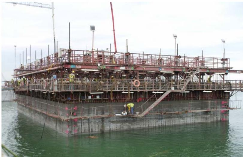
Tras la colocación de las tapas de remolque, los cajones son transportados a Blanes. Allí son acopiados y colocados sobre la banqueta de cimentación previamente ejecutada. Puede observarse el arranque de los diques en talud.
