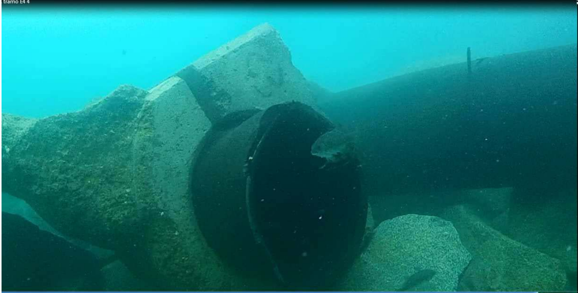
Tubería de PE rota por accidente
