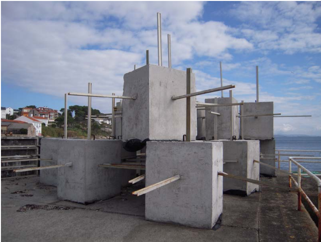
Antiarrastreros, acopiados en tierra, antes de su instalación.
