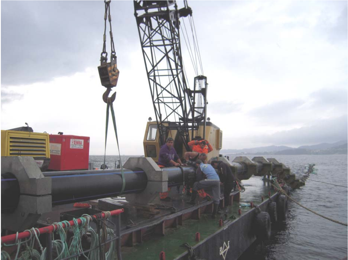
La flexibilidad de las tuberías de PE es una gran ventaja
