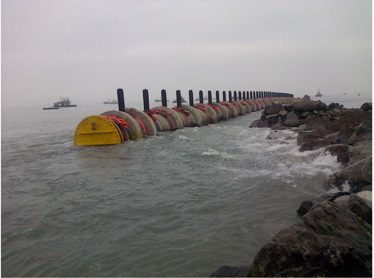
Transporte flotando de la tubería del Emisario de La Taboada (Lima-Perú). Tramo difusor.
