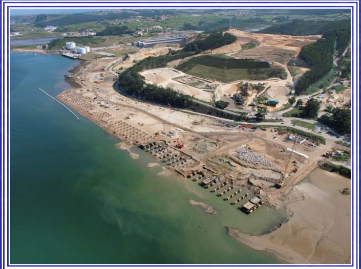
Ampliación Puerto Avilés Margen Derecha
