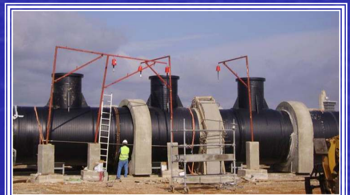
Circuito de refrigeración de la Central Térmica de Algeciras (España). Vista del tramo difusor Di=2.400 mm
