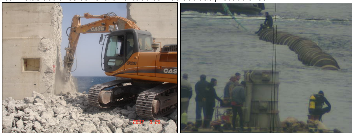
Figuras 1 y 2. Demolición del espaldón y fondeo del emisario
