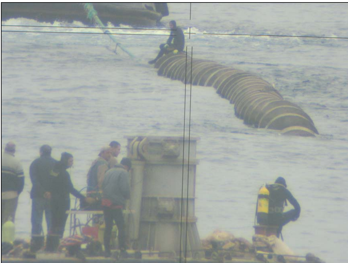
Fondeo de tubería (900 mm de diámetro exterior) de PE en el emisario de Arinaga (Gran Canaria). Por la perspectiva, sólo se ven los lastres de hormigón.
