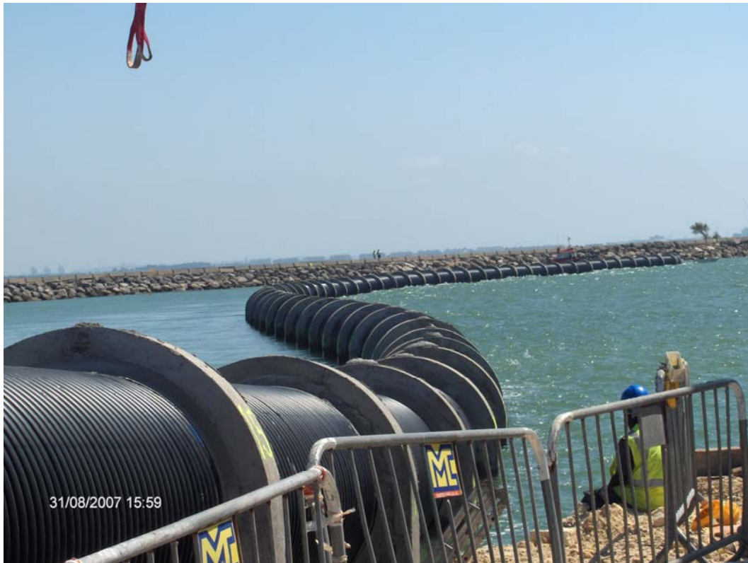
La flexibilidad de la tubería de PE es una gran ventaja
